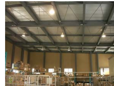
* 省エネ照明に取替えた倉庫内
